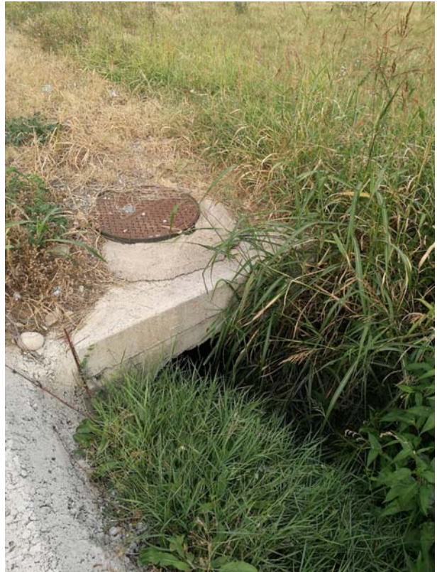
FOTO 6: tratto terminale tombinatura fosso nord via Emilia CLS DN1000 e inizio tratto a cielo aperto
