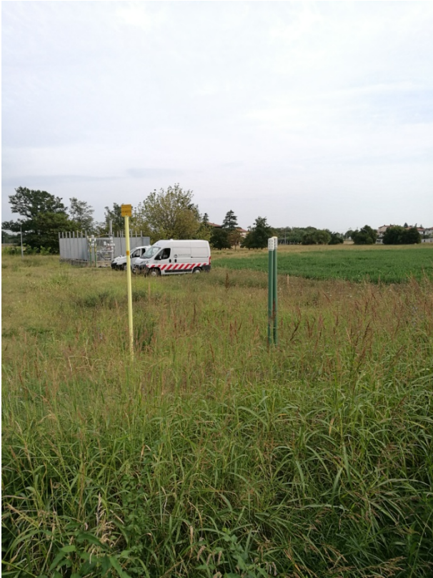
FOTO 7: linee SNAM (sfiati e paline) e cabina di intercettazione
