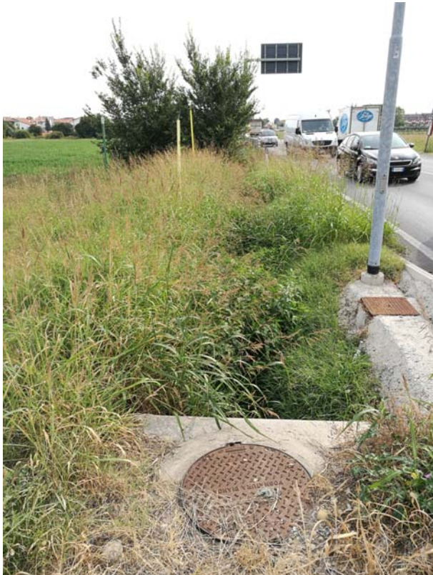
FOTO 5: fosso nord via Emilia, inizio tratto a cielo aperto con paline segnalatrici/sfiati metanodotti SNAM
